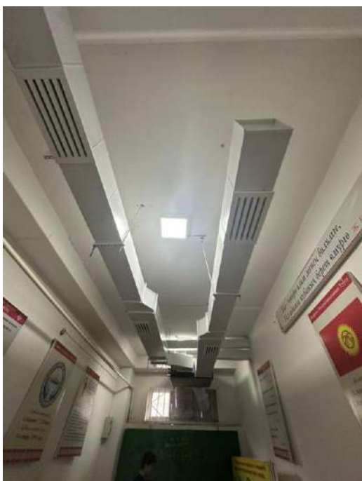
Башкы корпустун подвалына орнотулган желдетүүчү система
